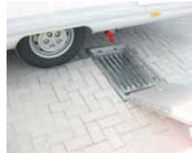
So kann eine Ver- und Entsorgungsstation beispielsweise aus- sehen (links). Die Abwasserentsorgung erfolgt über ein Spül- gitter (oben).
